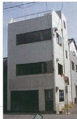
改修後完成写真 15年4月完成
