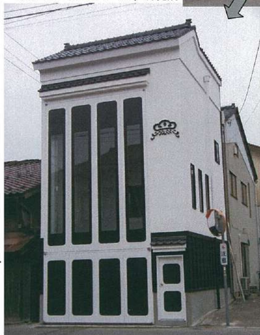
松ヶ下区山車格納庫の改修
