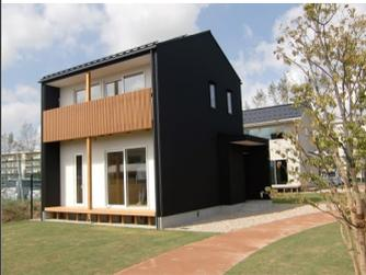
解体した時30年以上を経ても、腐蝕のなかった柱や梁などの木材はそのまま利用して、断熱性能を重視した高性能型のエアサイクル工法のモデル住宅です。
