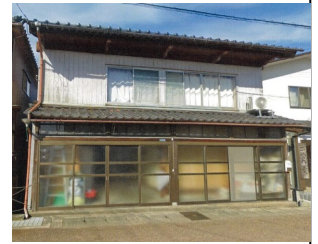
着工前の外観写真
