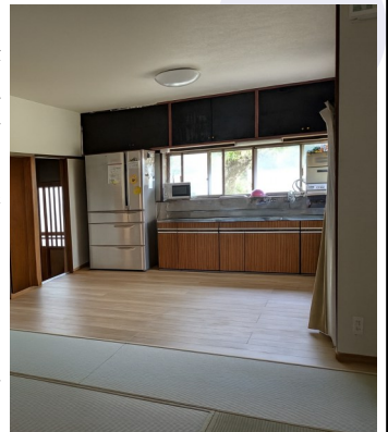
和室と台所の床の段差をなくするためのバリアフリー工事
